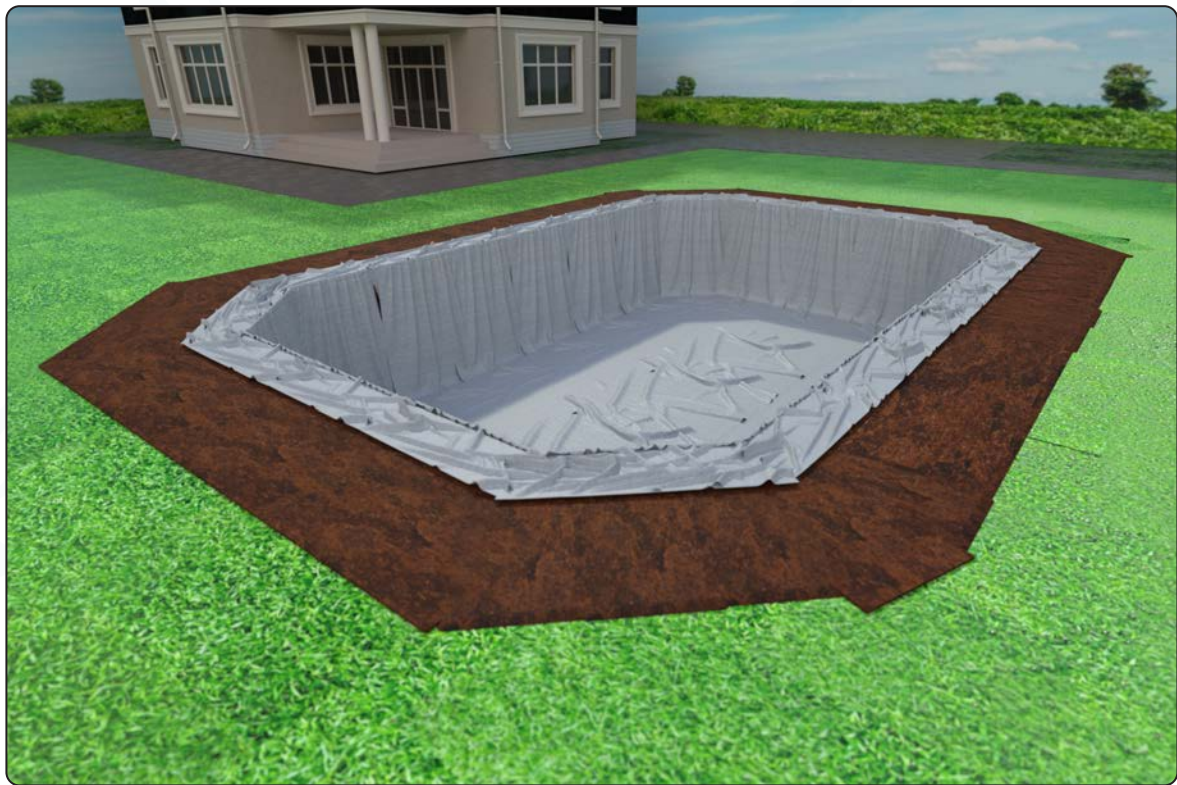
Geotextvlies vollflächig ausgelegt
