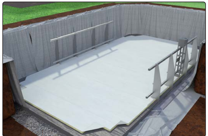
Vlies vollflächig ausgelegt
