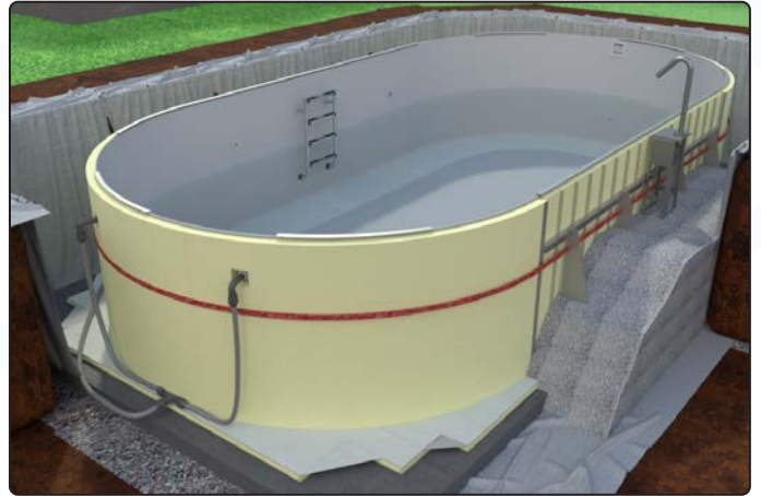
Kies auf gleiche Höhe wie Wasserstand füllen
