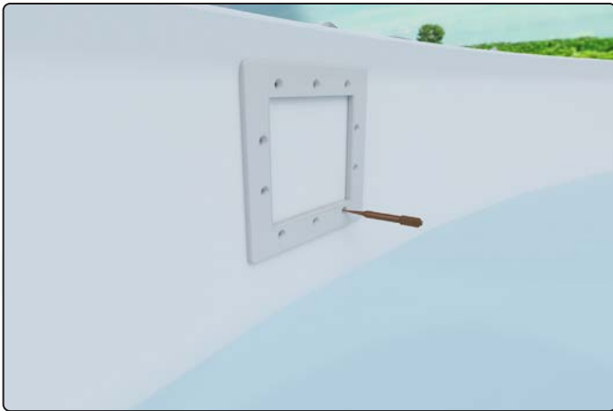
Lochbild nach Innenflansch anzeichnen und vor- stechen
