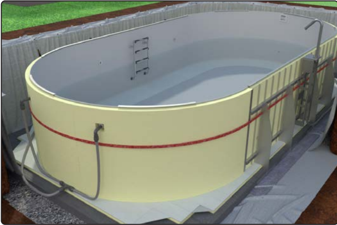
Becken bis auf 60cm Höhe befüllen
