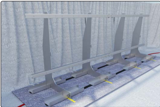
Querträger montiert
