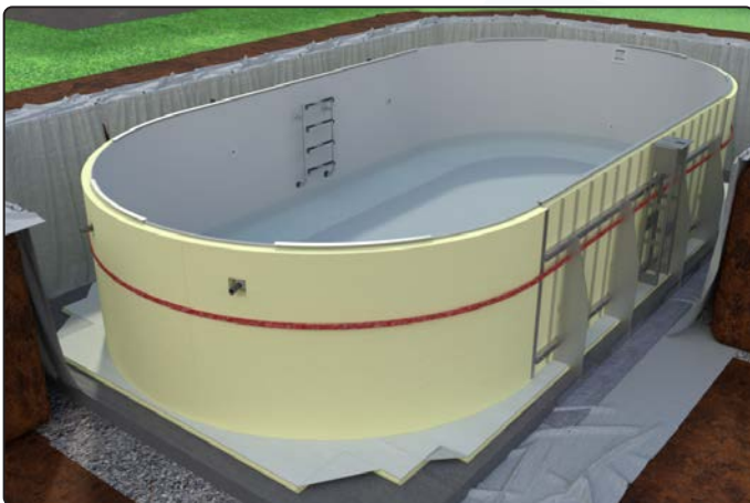
Rundschalungselemente mit Gurt o.ä. fixieren
