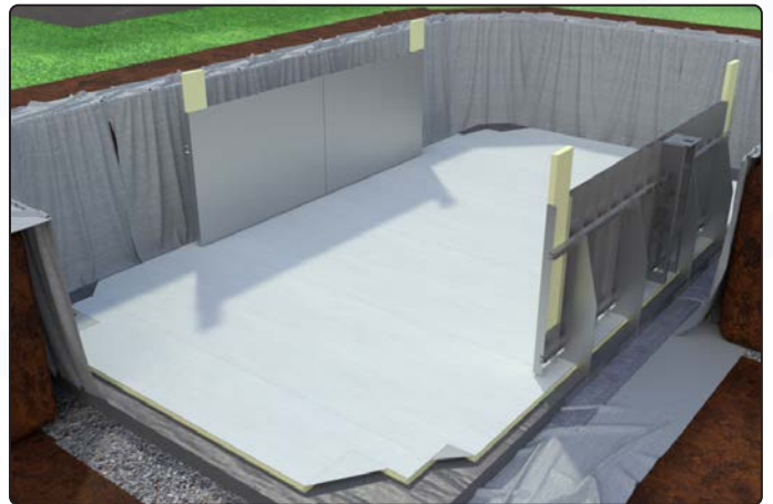
Äußere Wanddämmung einschieben
