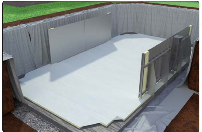
Fertig montierte Stützwand
