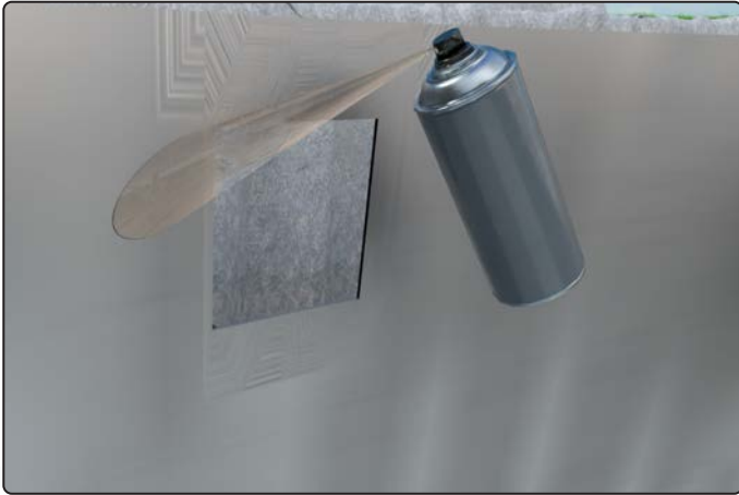
Skimmeröffnung entgraten, verzinken
